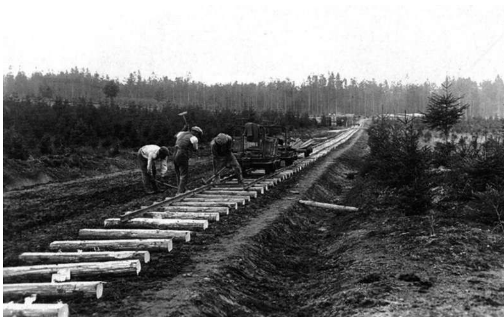
Stavba lesní železnice u Velkého Dářka v roce 1931 (pro odvoz dříví po kalamitě z roku 1930). (Archiv autora)
